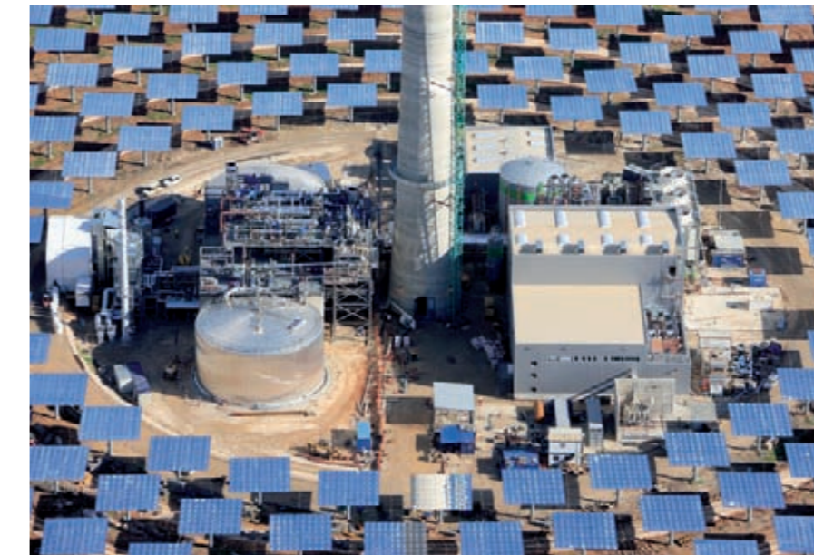
Sistema de almacenamiento de sales fundidas en la planta Gemasolar Molten salts storage system at the Gemasolar Plant
